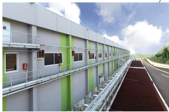
(2) BIOFILTRO PER ABBATTERE GLI ODORI DEL PROCESSO
